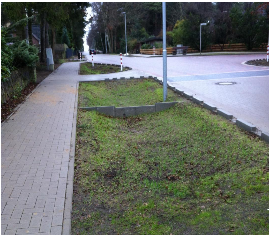
Figur 15. Dike utformat med terrasser för att kvarhålla vatten så att det kan infiltrera.
