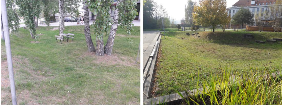
Figur 20. Tv, exempel på en torrdamm i Huddinge för magasinering av dagvatten vid behov. Th, exempel på en större torrdamm i Basel där dammen integrerats som park. Foton: WRS
