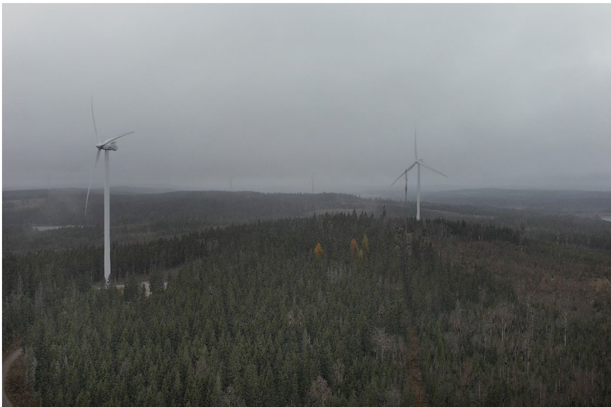
Vindkraftverk i Garpenberg (Sweco AB).
