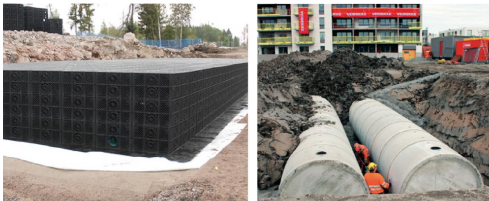
Figur 7. Exempel på hur avsättningsmagasin kan utformas. Den vänstra bilden är ett kassetmagasin och kommer från Uponor medan den högra föreställer ett rörmagasin och kommer från Meag Va-system.
