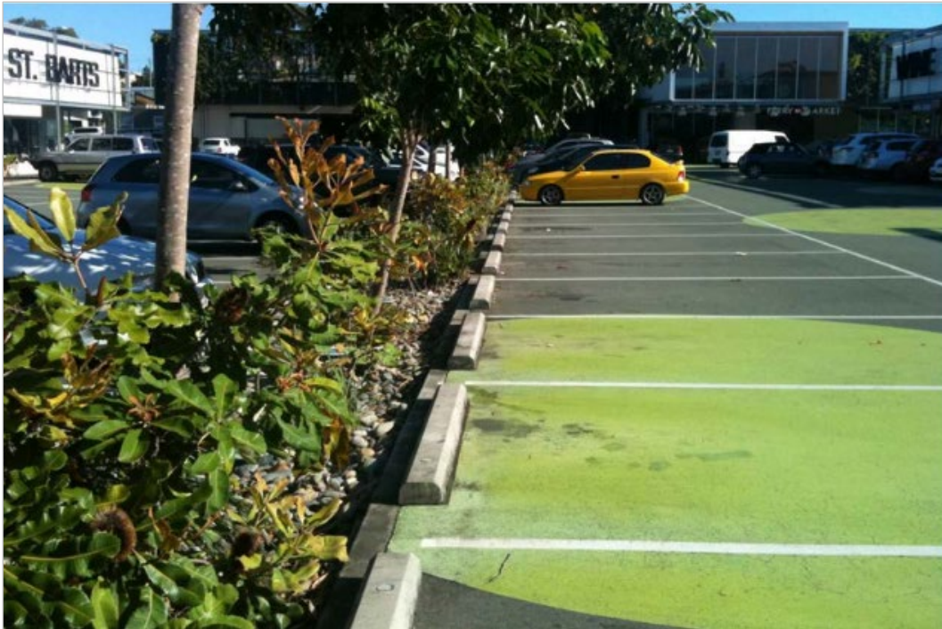
Figur 5-8: Öppning i kantsten, inlopp växtbäddar (Waterbydesign, 2014)
