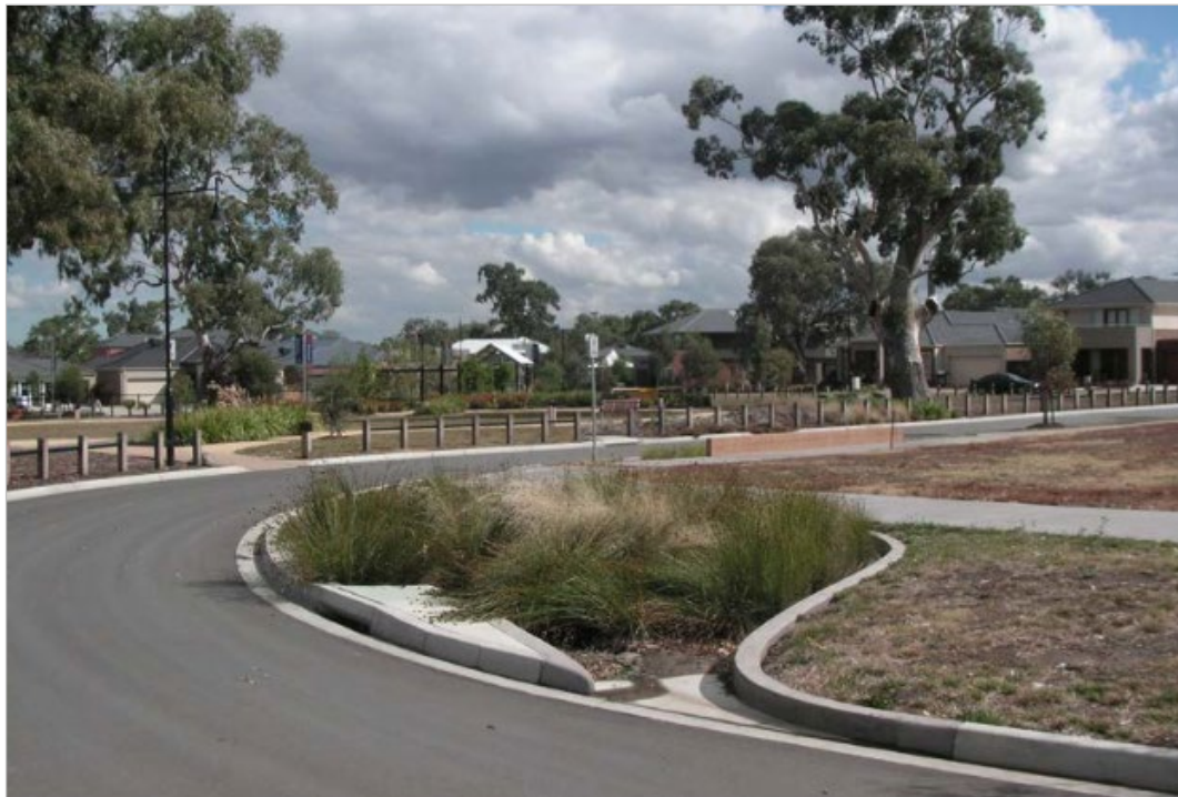
Figur 5-7: Öppning i kantsten, inlopp till växtbädd (Waterbydesign, 2014)
