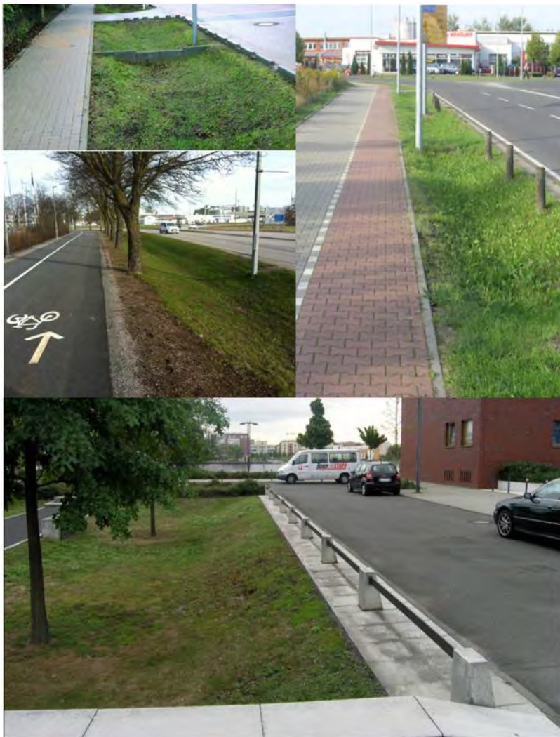
Figur 2. Exempelbilder för svackdike (Foto: WMS).
