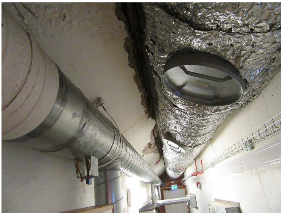
BILD 15. Spjälkning under skvalprännen, kortsidan österut.
