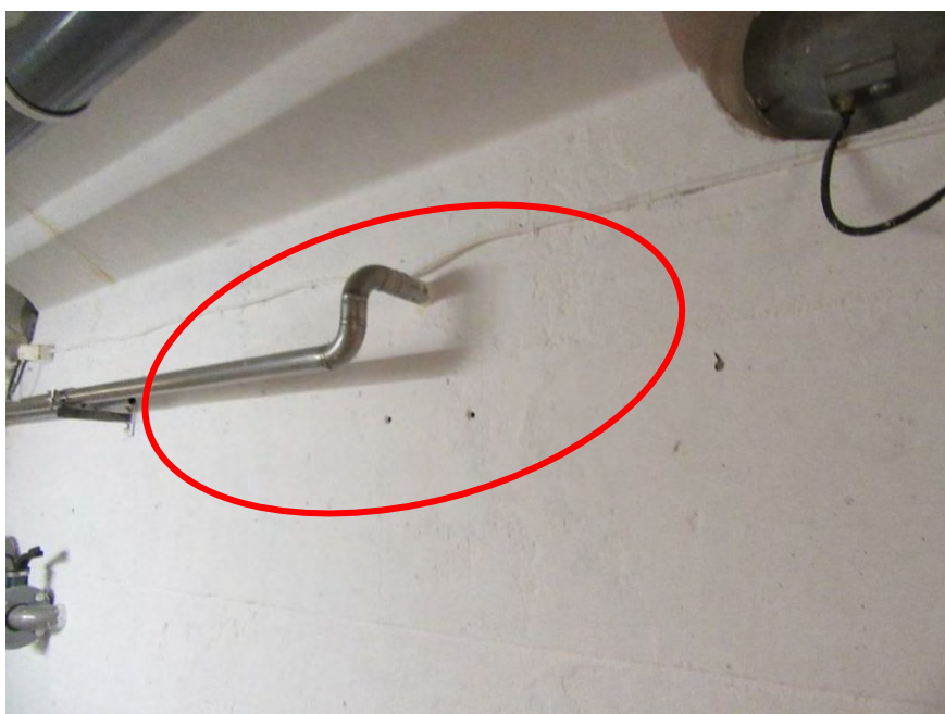
BILD 5. Bomparti. 2x2m kring rörgenomföringen.
