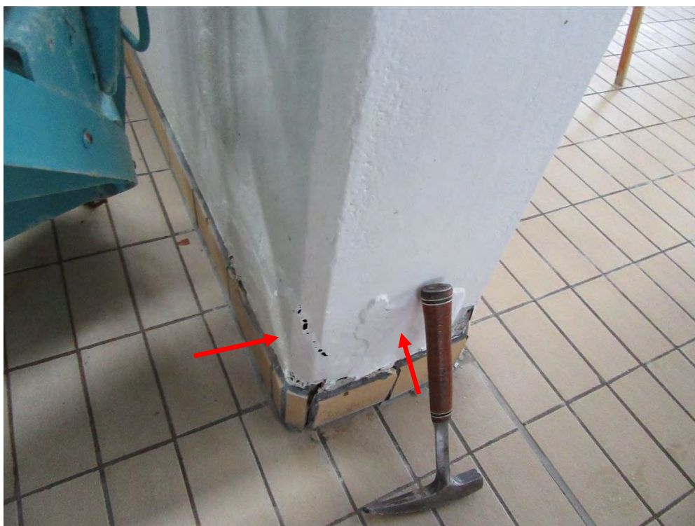
BILD 33. Hopptornet med armeringskorrosion och bompartier i nedre del.
