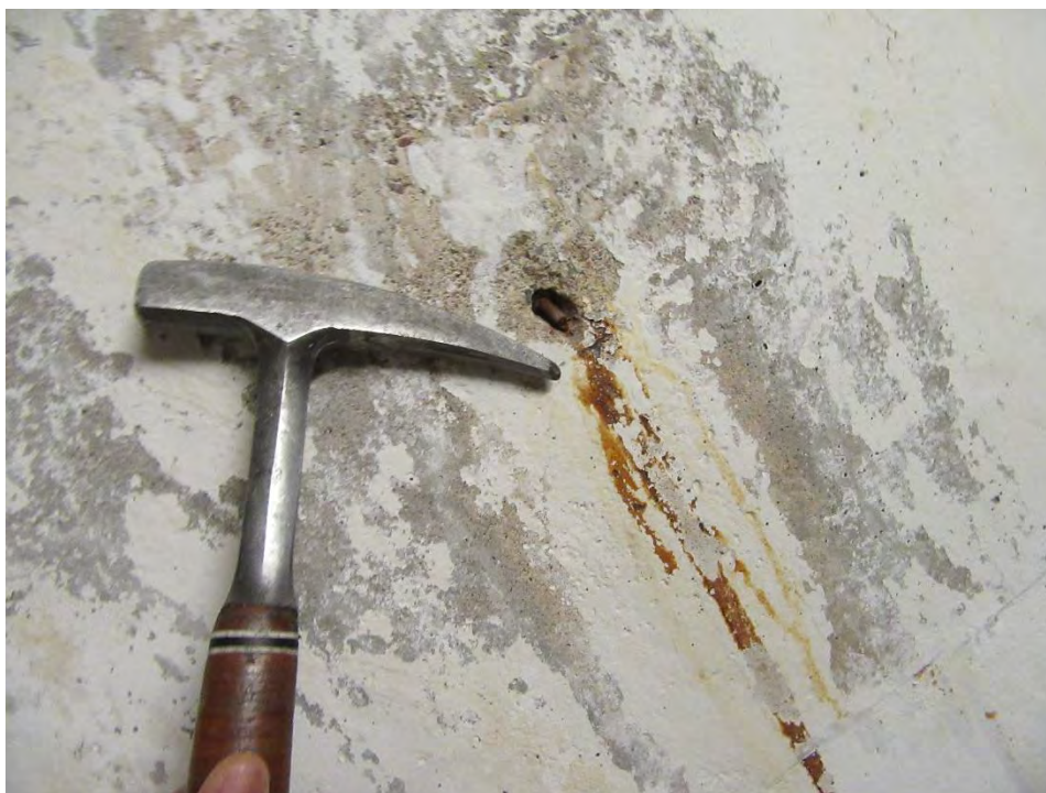
BILD 14. Spår från tidigare injektering.
