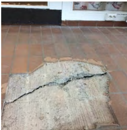
Figur 2.4.1 – Tidigare skada som åtgärdats.
