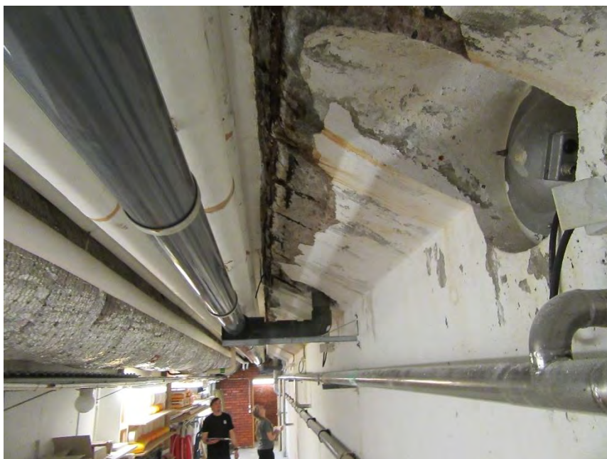
BILD 4. Översiktspå bild på långsidan, norra väggen. Spjälkningar orsakat av armeringskorrosion under skvalprännen.
