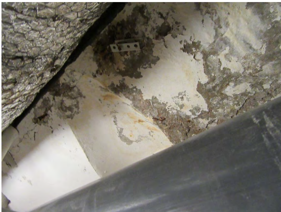
BILD 8. Avflagningar under skvalprännan.
