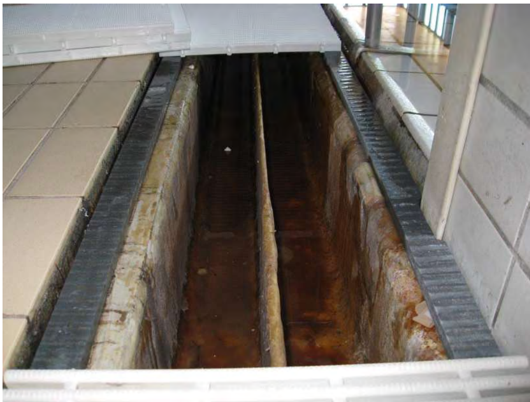
BILD 3: Skvalprännan till stora bassängen är relativt nygjord med plast.
