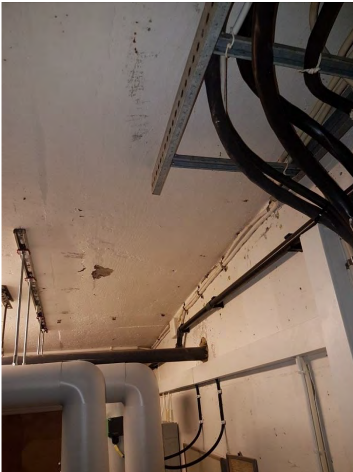
Foto 13. Läckage i anslutning till bjälklag, Övningsbassängen
