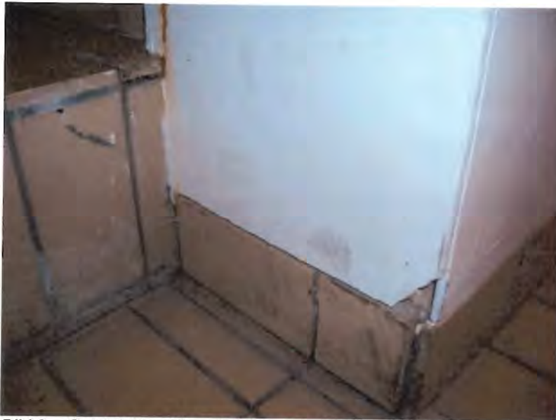
Bild 9 – Golvklinker vid anslutning mot schakt och läktare.
