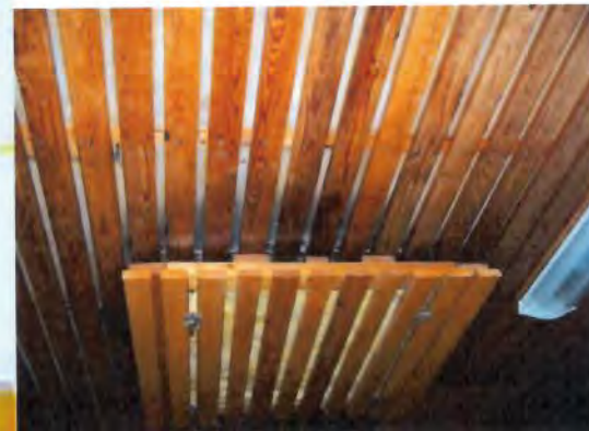
Termogram 8, Avkyld anslutning runt lucka till äldre ventilationshuv.
