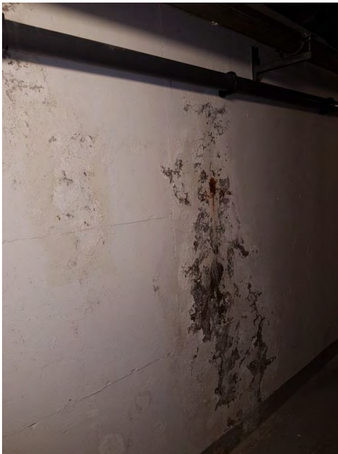
Foto 6. Läckage i spricka Stora bassängen
