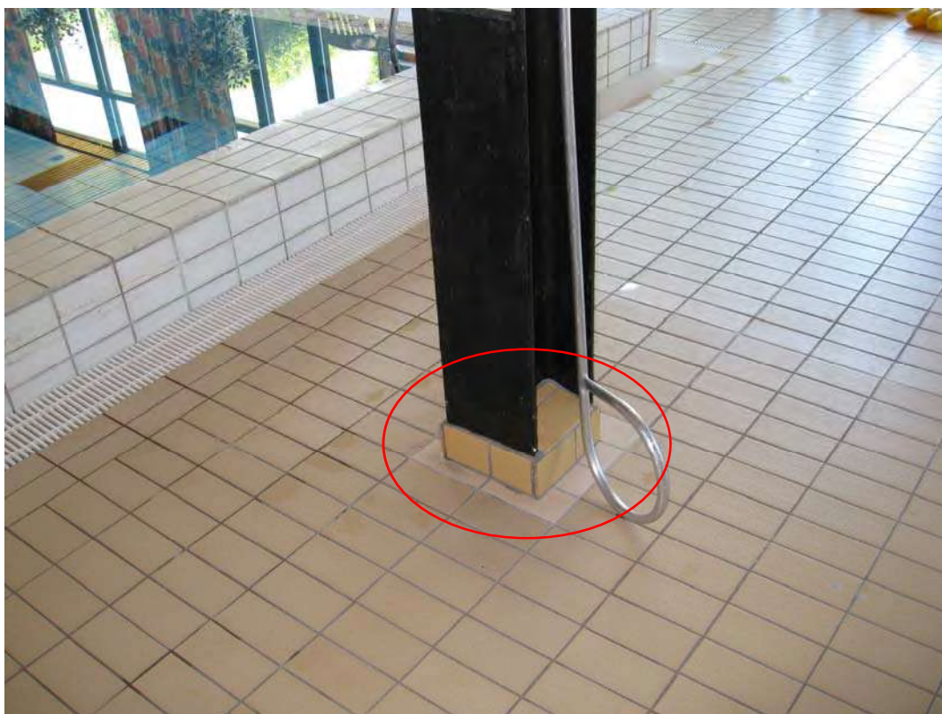
BILD 4: Reparerad pelarfot invid stora bassängen.
