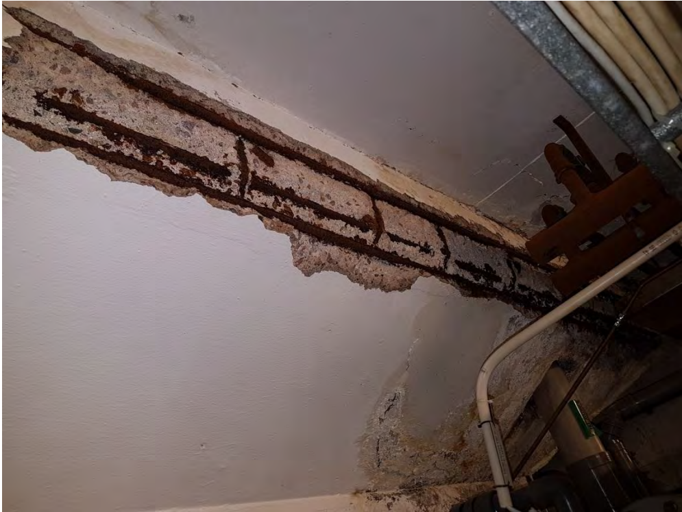
Foto 13. Läckage i anslutning till bjälklag, Övningsbassängen
