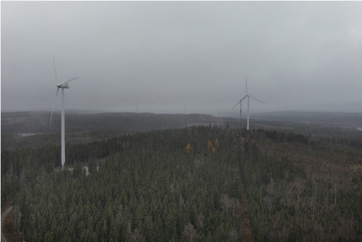
Figur 16: Vindkraftverk i Garpenberg (Sweco AB).
