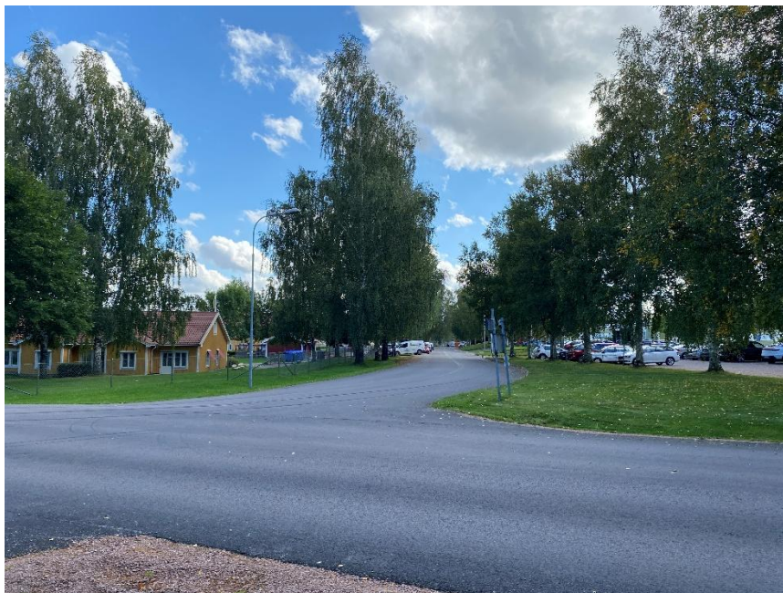
Figur 14: Korsningen mellan Prostmyrsvägen och Vinstravägen.
